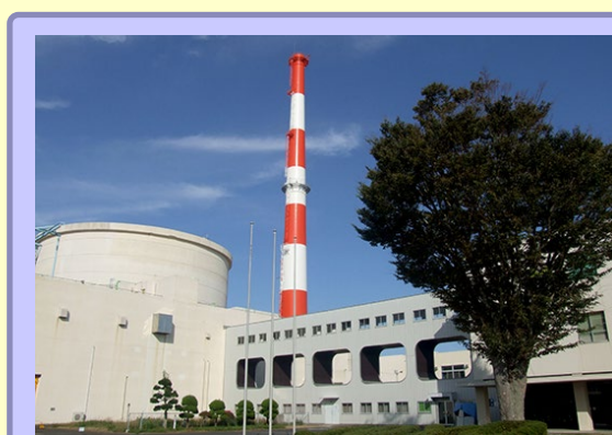
高速実験炉「常陽」
